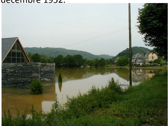
Saint-Chamant, station de relèvement de l'eau potable – juillet 2001
